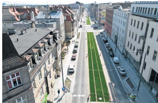
Od soboty, na przebudowane torowisko ul. Wierzbicie wracają tramwaje
